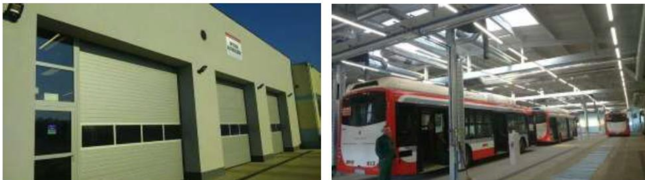
Rysunek 37. Hala postojowa zajezdni autobusowej MPK w Częstochowie
